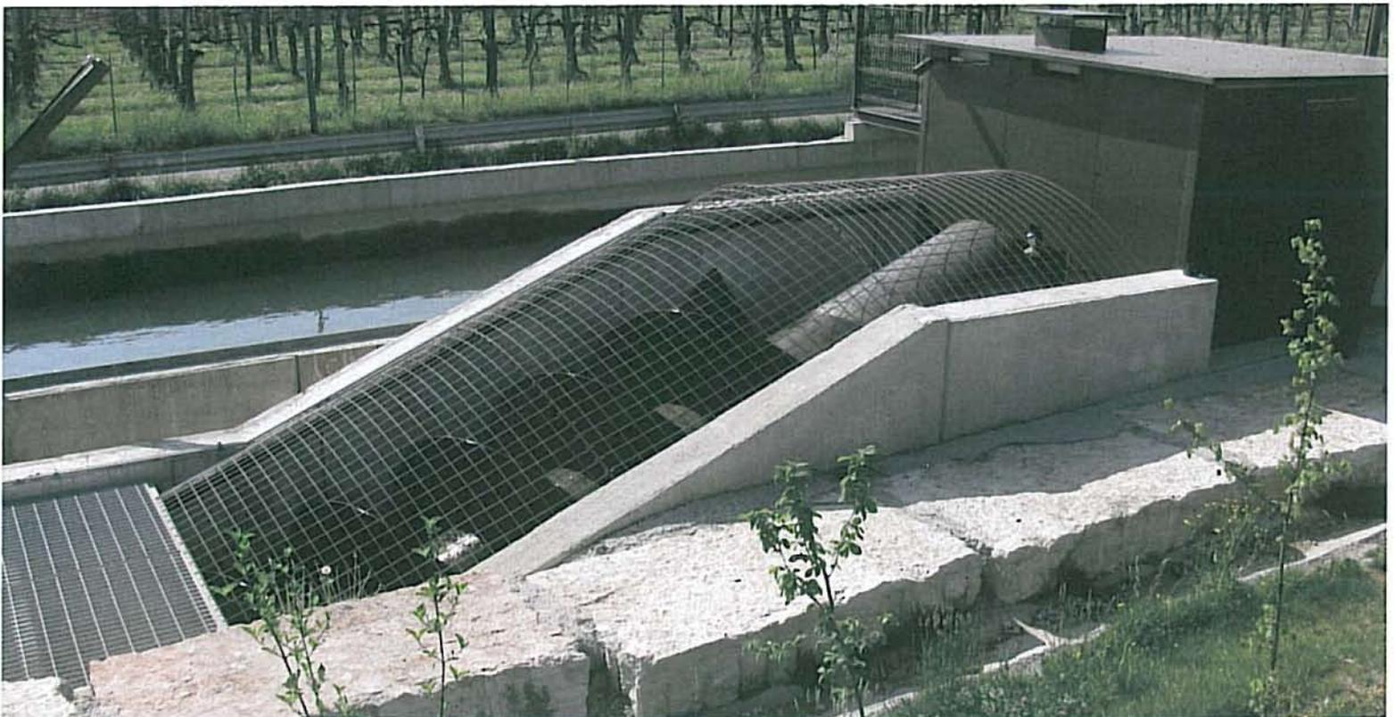
↑ Foto 1. Particolare di coclea idraulica in impianto microidroelettrico
